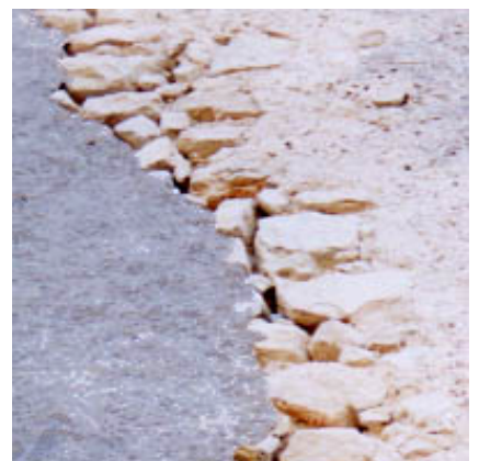
13 - L'humidité bloquée par le ciment (à gauche) ressort et désagrège l'enduit à la chaux qui reste stable à droite.
