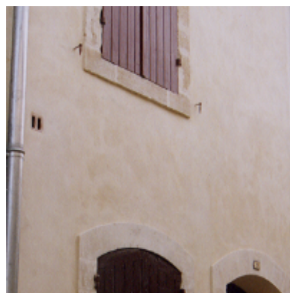
26 - Enduit teinté par le sable
