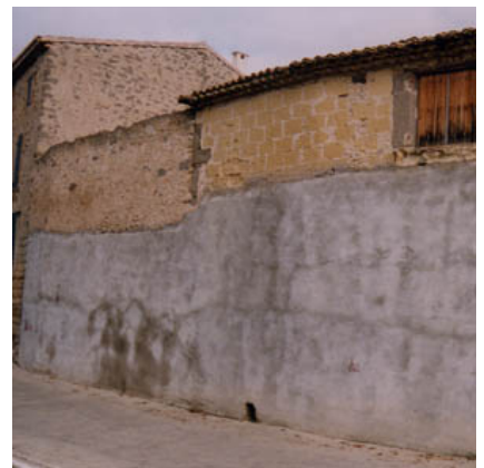
6 - Enduit ciment inadapté
